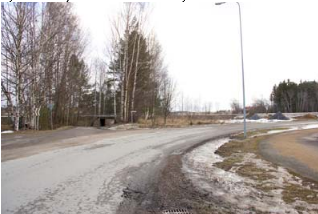
Kyttäläntien ja Sammontie risteys sekä Roholaan johtava alikulku
